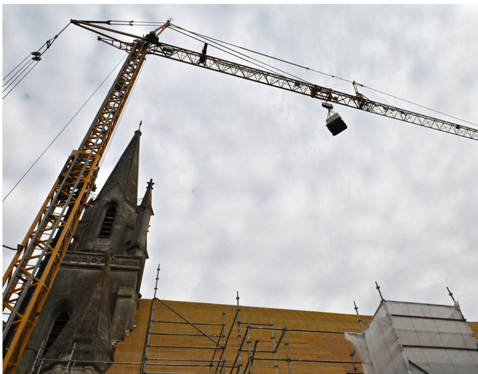
Hissage des tuiles à l'aide de la grue.
