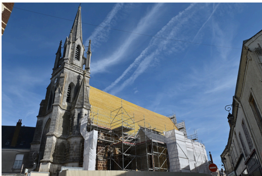
Lattage de la charpente.
