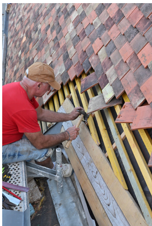
Finitions du raccord entre la toiture et la gouttière.
