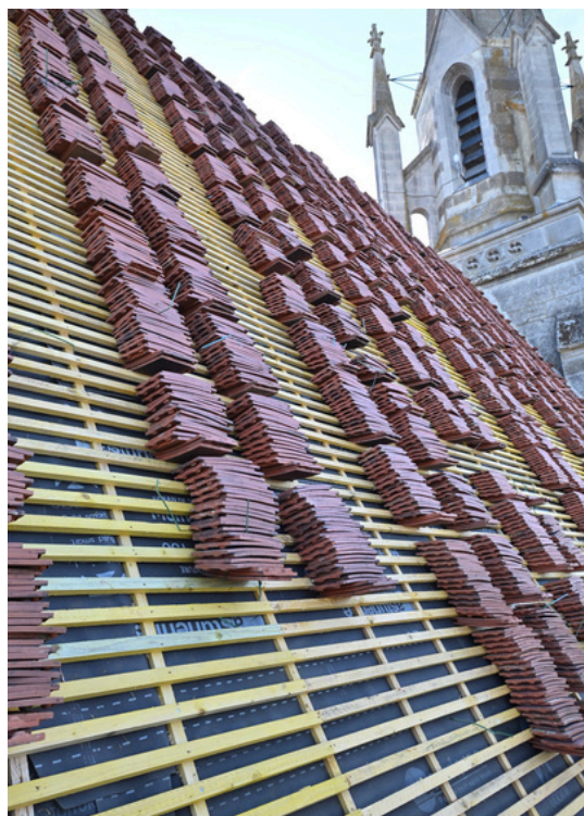
Préparation des tuiles avant installation.
