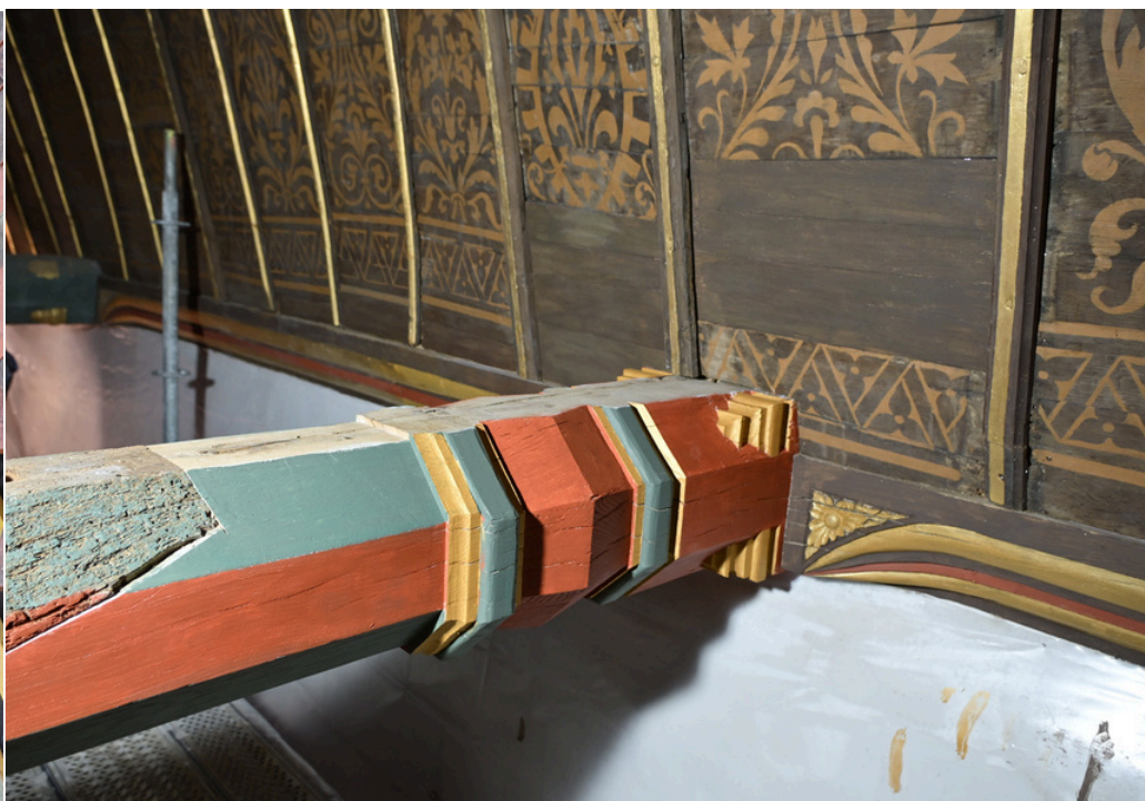
Restauration des entrails.
