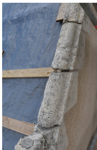
Restauration des pierres du pignon Est. Certaines sont totalement remplacées et taillées sur place. Un travail à la chaux permet d'éviter les infiltrations, travail préalable à la pose des tuiles. Restauration d'un contrefort.
