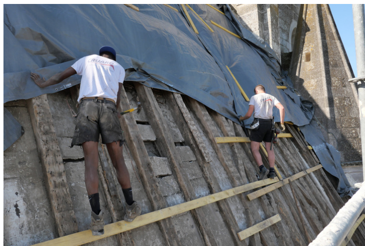
Les charpentiers en action, plaques de liège apparentes qui étaient utilisées pour l'isolation de la voûte et qui seront maintenues.
