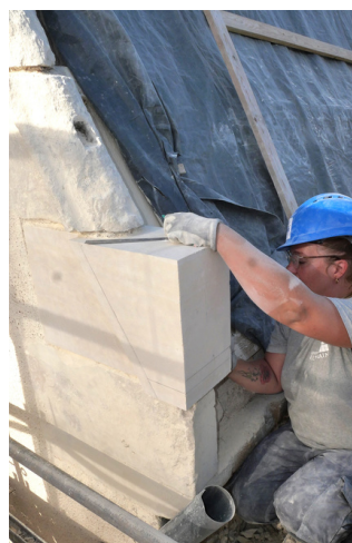
Restauration des pierres du pignon Est. Certaines sont totalement remplacées et taillées sur place. Un travail à la chaux permet d'éviter les infiltrations, travail préalable à la pose des tuiles. Restauration d'un contrefort.
