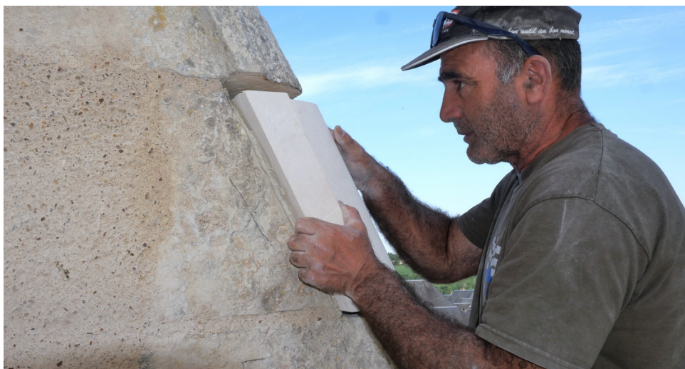
Pierre neuve posée avec application sur le pignon Est.
