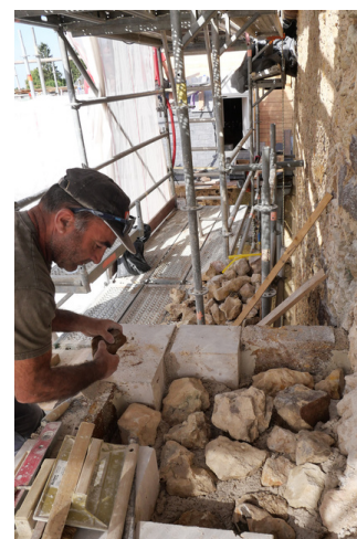
Restauration des pierres du pignon Est. Certaines sont totalement remplacées et taillées sur place. Un travail à la chaux permet d'éviter les infiltrations, travail préalable à la pose des tuiles. Restauration d'un contrefort.
