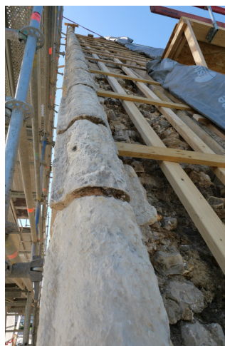
Les charpentiers en action, plaques de liège apparentes qui étaient utilisées pour l'isolation de la voûte et qui seront maintenues.
