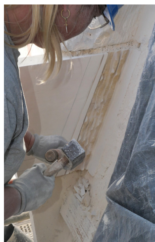
Restauration des pierres du pignon Est. Certaines sont totalement remplacées et taillées sur place. Un travail à la chaux permet d'éviter les infiltrations, travail préalable à la pose des tuiles. Restauration d'un contrefort.
