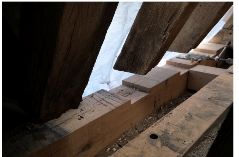
Travaux sur sablières chapelle nord.
