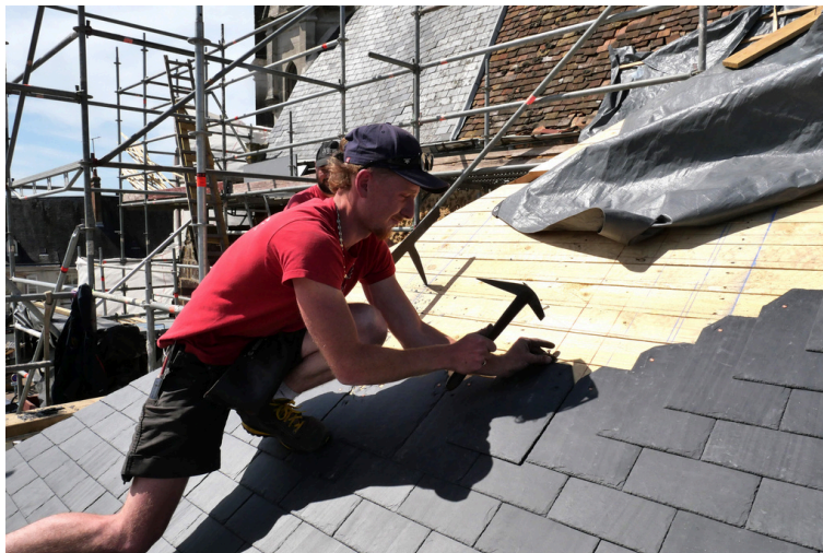
Couvreurs en action sur la chapelle sud.
