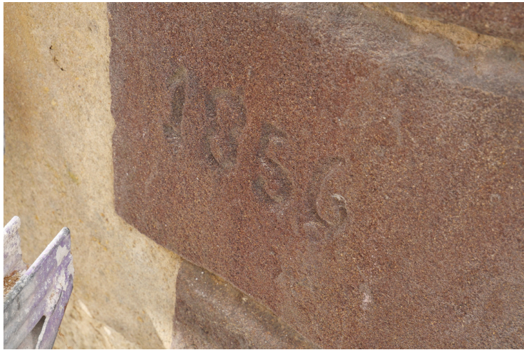
Trace d'anciennes restaurations.
