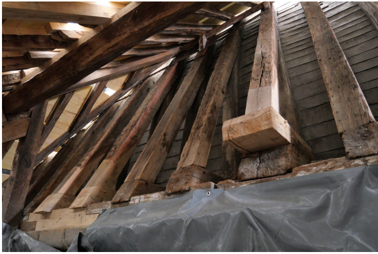
Remplacement des sablières.
