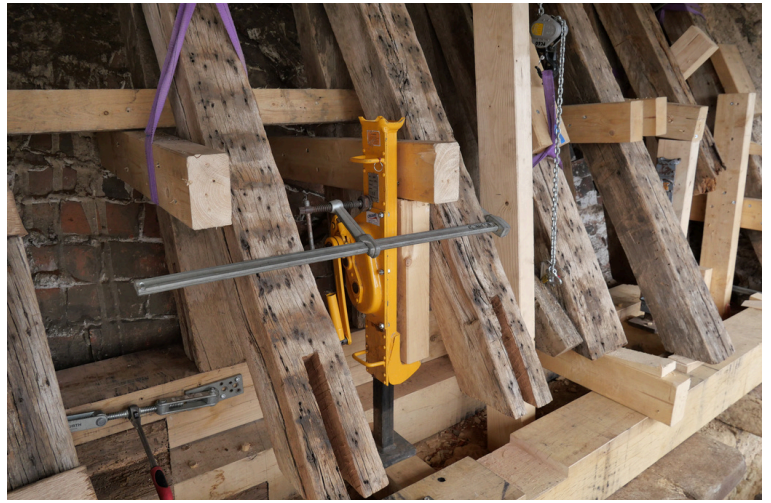
Technique de remplacement de sablières.
