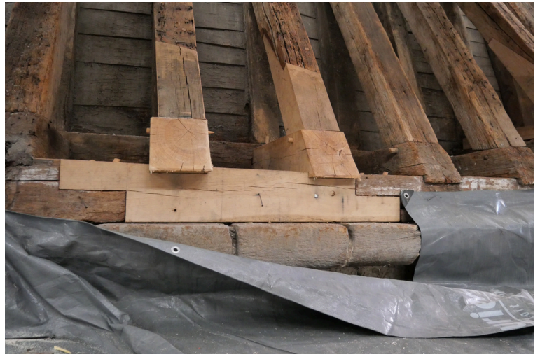
Sablères et pieds de charpente.
