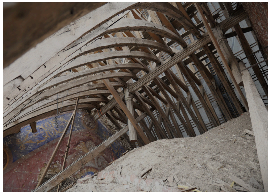
Charpente, fresque, vestiges de poinçons au-dessus de la voûte du chœur.
