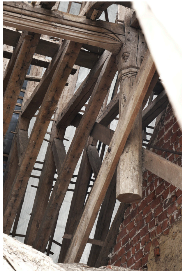
Charpente et reste d'un poinçon.
