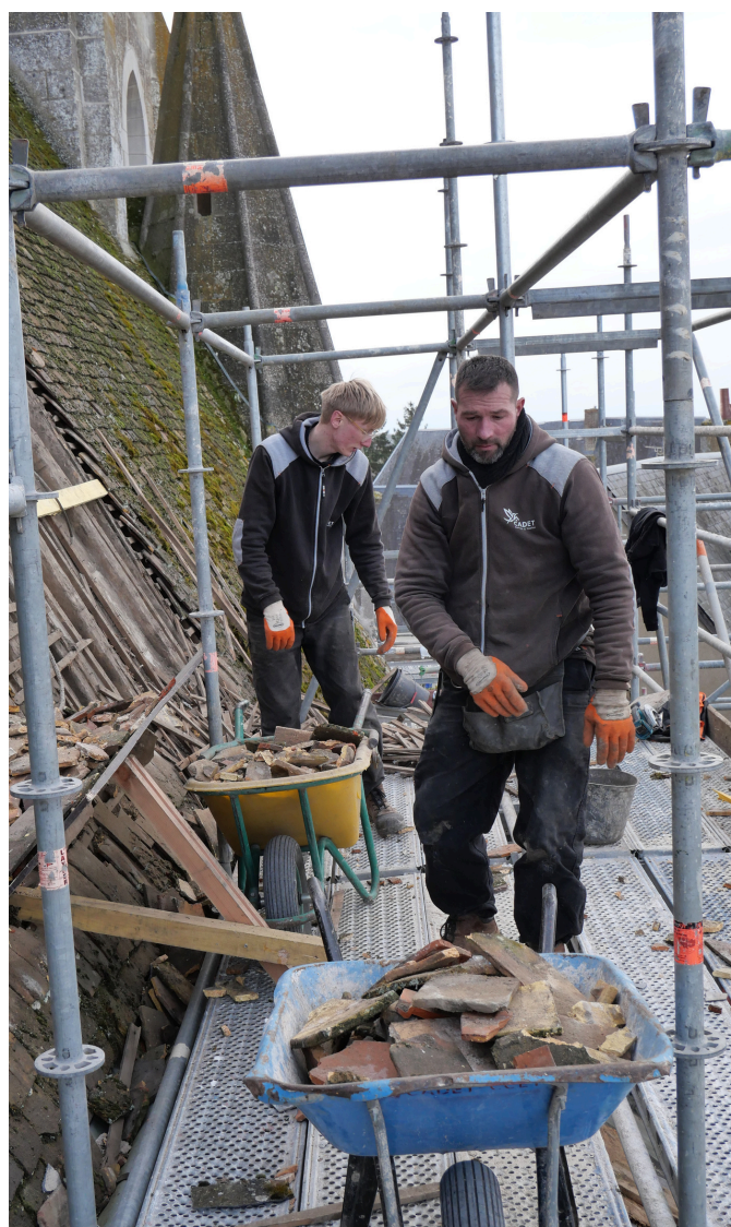
Récupération des tuiles usagées
