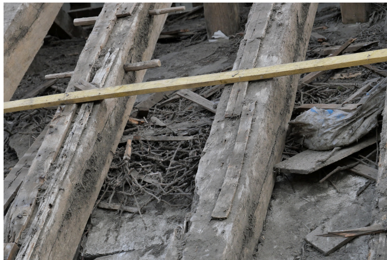
Sous la charpente
