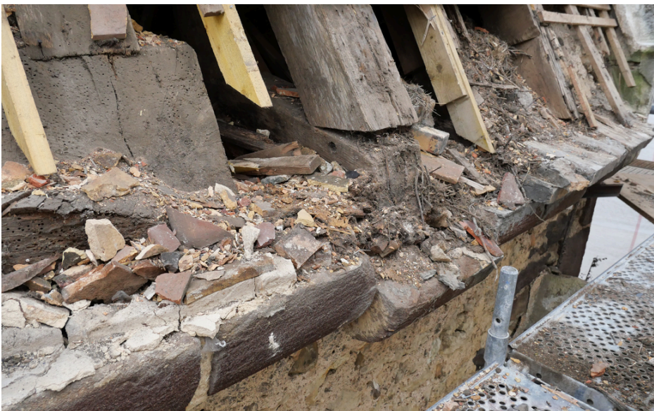
Dégats dûs à la poussée de la charpente
