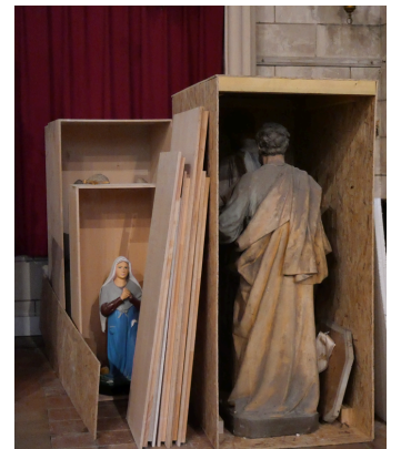
Protection du mobilier et isolation de la chapelle de la Vierge
