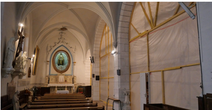
Dégats dûs à la poussée de la charpente
