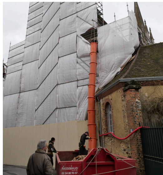
Evacuation des tuiles usagées
