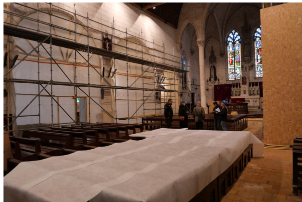
Protection du mobilier et isolation de la chapelle de la Vierge
