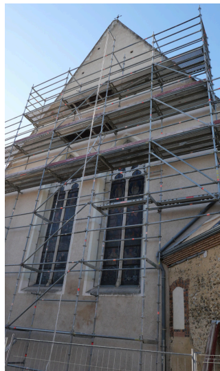
Echafaudages du chevet
