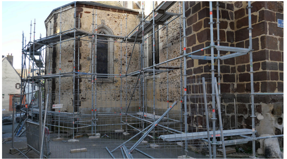
Novembre 2025 : début d'installation des échafaudages
