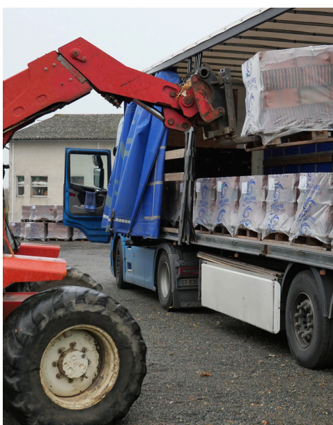
Déchargement des tuiles
