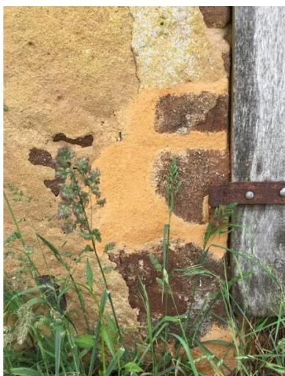
*Reprise d'un enduit avec du sable de Sargé sur Braye (Les Pierres du Breuil)*
